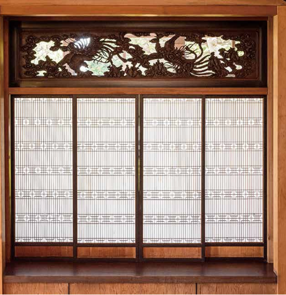
主日式客厅的付书院 主厅壁龛旁边向走廊的突出部分被称为付书院， 上部榻窗上的凤凰透雕惟妙惟肖， 日式拉窗上木条组合的图案尽显文雅精致。
